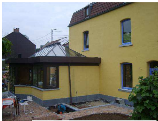
Enduits à la chaux sur moellons
